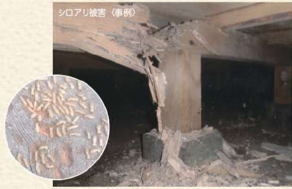
シロアリは、直射日光に弱く、人目に触れる所には現れません。大引きがすっかり食われて、床を支えられていません。
